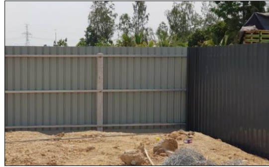
รูปที่ 4.1.5-3 ตัวอย่างรั้วชั่วคราว (Aluminum Sheet)
